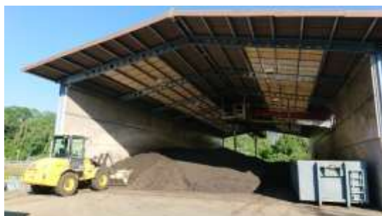
Schlammhalterhalle mit Offenverlad
